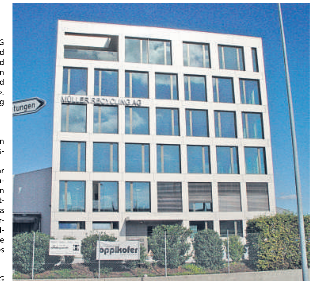
So präsentiert sich der formvollendete Bau von aussen.
